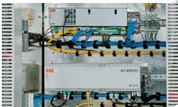
UNITROL® 6000 的 测量单元和控制通道
